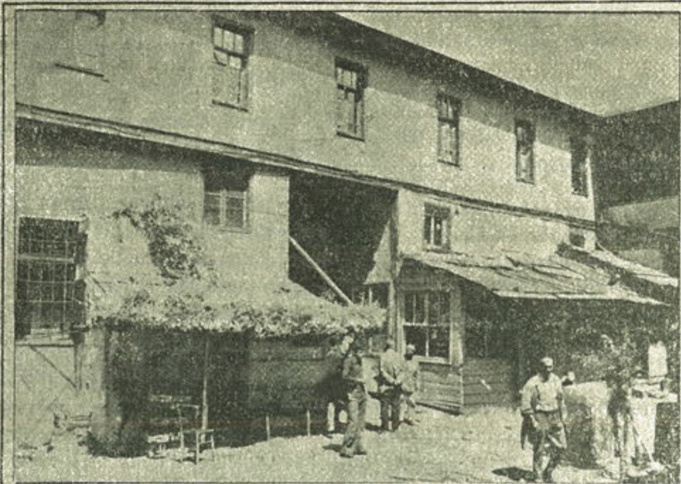
Ankara'daki hanlar arasındaki kâdime terk edilmiş bunlardan biri de Çukur Han. Zamanın en güzel örneği olması nedeniyle eski Malîye Vekili Cavit Bey, uzun süre burada ikamet etmiş. Burada da şimdi, üçüncü sınıf otel ve depo olarak kullanılıyor. Bodrumu da bodrumunda dört dâbakhane var. (FOTO: HURRIYET - ÖZEL)
